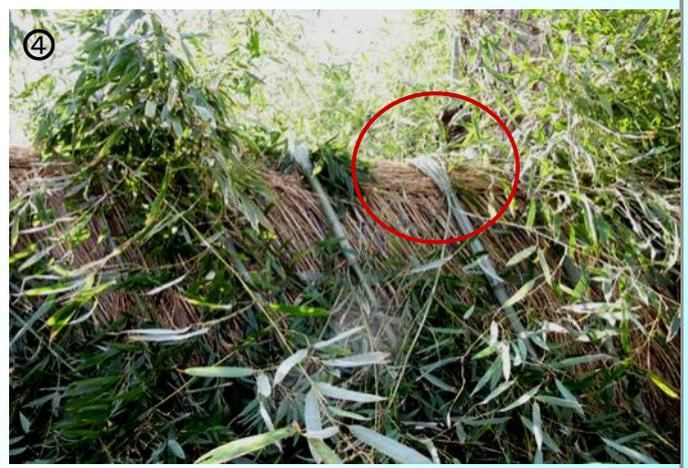
内側から表にL字型に折り曲げた竹の部分写真です。○印の部分では折れ曲がっているのが見えます。
