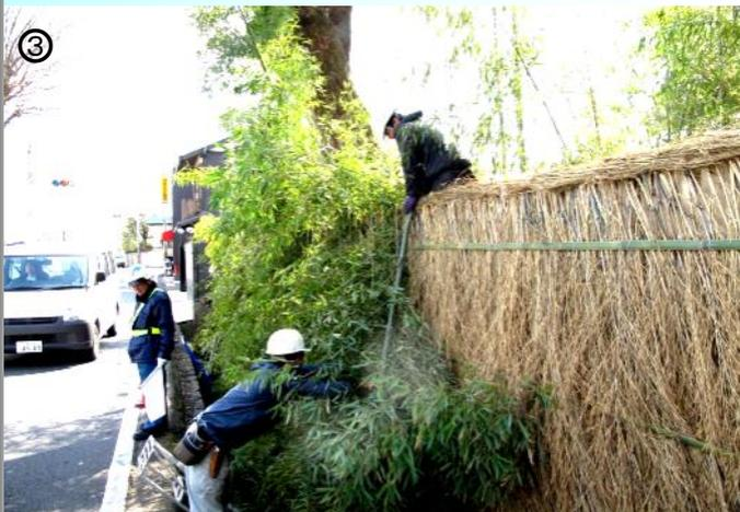
内側からの竹を曲げる部分に縦に割れ目を入れ、生垣として編みつけていきます。
