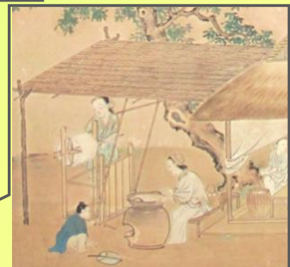
③繰糸…繭から糸を巻き取る作業
