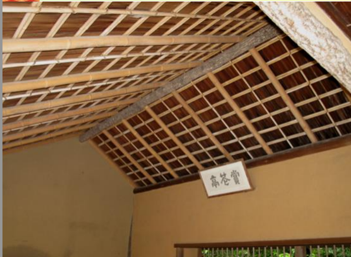
化粧屋根裏天井(桂離宮:賞花亭) しょうかてい
