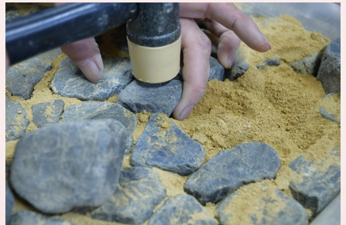
③ 石の打ち込み
