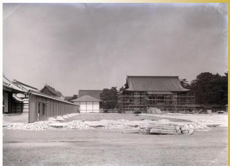
春興殿前建物解体風景【昭和4年9月】 (京都事務所保存のガラス乾板より)
