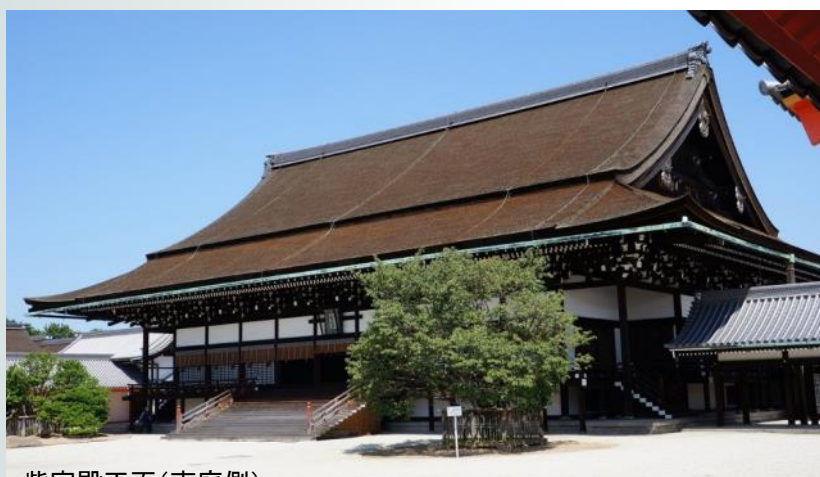
紫宸殿正面(南庭側)
