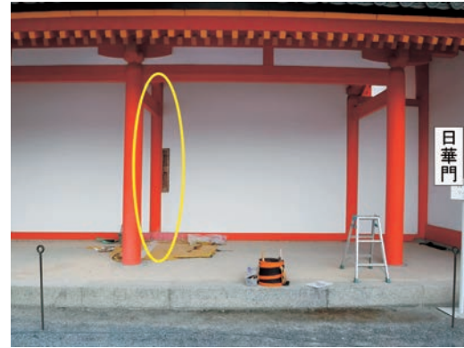
図2 試料採取箇所 (黄丸で囲んだ円柱壁内部分)
