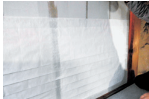
図10 蓑掛け施工の様子
