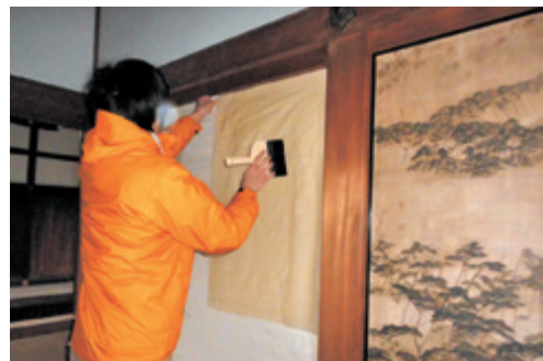
図11 蓑縛り施工の様子
