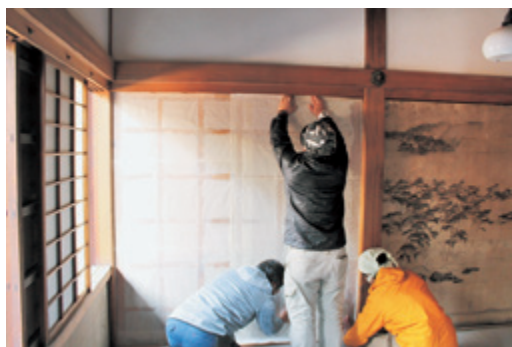
図7 骨縛り施工の様子
