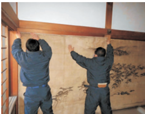
図15 上張り施工の様子
