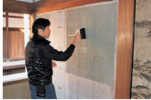
図9 胴張り施工の様子
