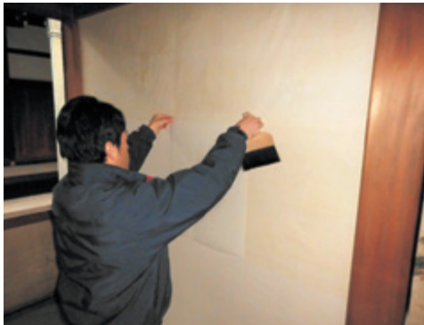
図13 浮縛り施工の様子
