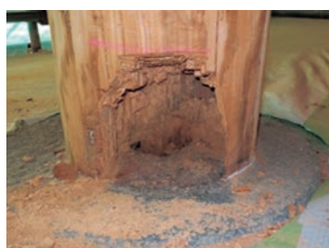
図28 回廊柱修繕前
