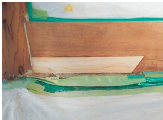
図38 月華門北側地覆修繕後
