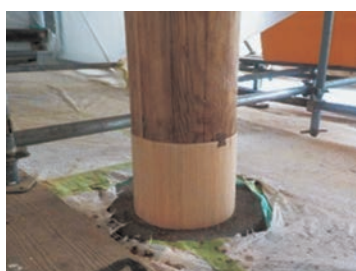
図32 回廊柱修繕後
