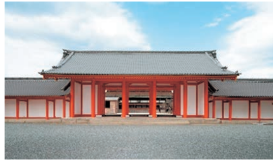
図2 承明門（工事後）
