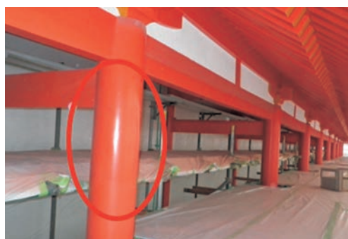
図5 回廊状況（工事前）
