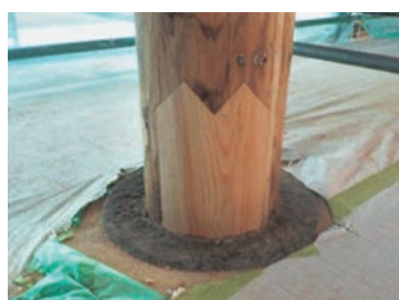
図31 回廊柱修繕後
