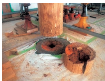
図29 回廊柱修繕前
