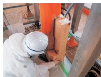
図30 回廊柱仕口調整
