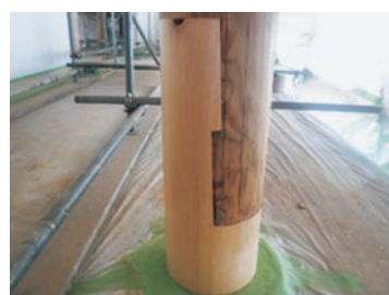
図33 回廊柱修繕後
