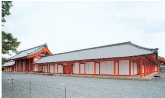
図1 回廊南東（工事後）
