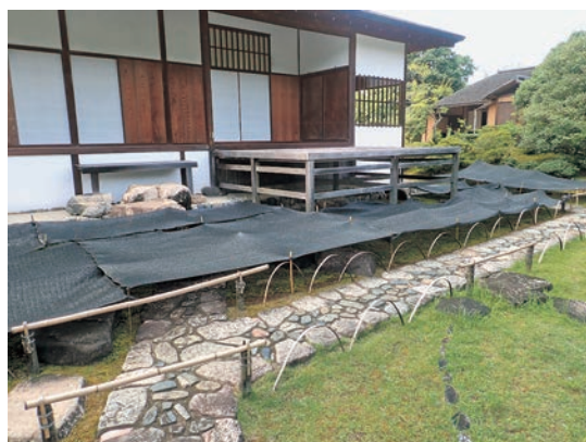
図7 遮光シート設置状況
