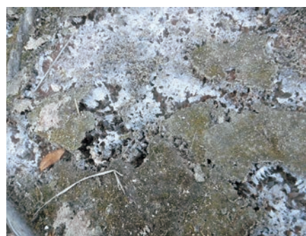
図8 霜柱による被害
