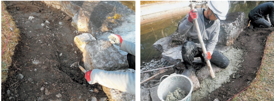
図13 陥没箇所の修理
