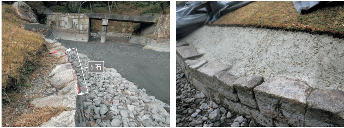
図15 護岸石組修理
