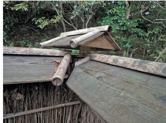
図8 止柱 養生屋根改修
