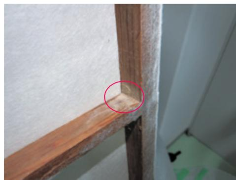
図17 下地骨への泥付着状況
