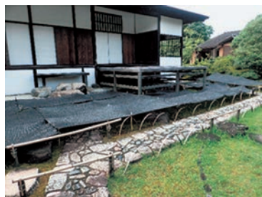
遮光シート設置
