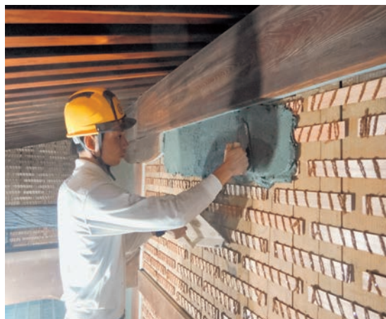
図28 荒壁塗（下塗）
