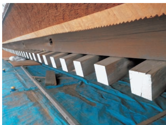
図38 垂木木口胡粉塗（塗替後）
