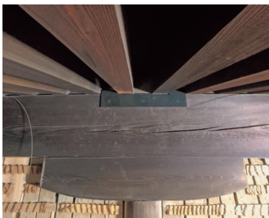
図51 補強金物設置（外側）
