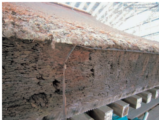
図8 水切銅板破断
