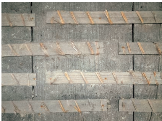
図25 既存へぎ板下地（稲藁使用）
