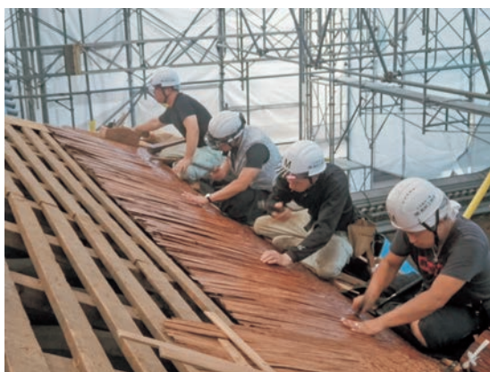
図9 平葺施工状況
