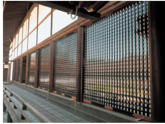
図32 蔀戸外部（塗替後）
