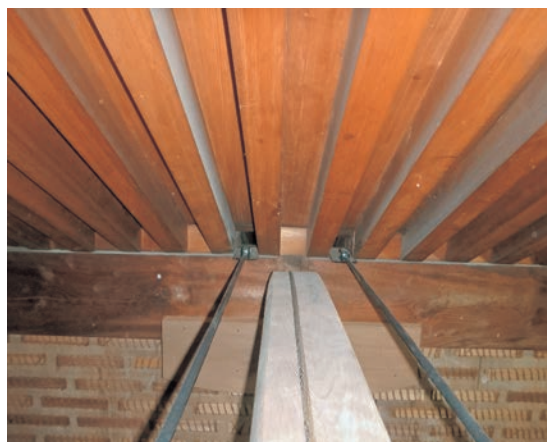
図52 補強金物設置（内側）
