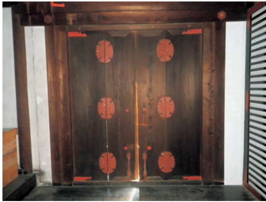
図39 板唐戸（工事前）
