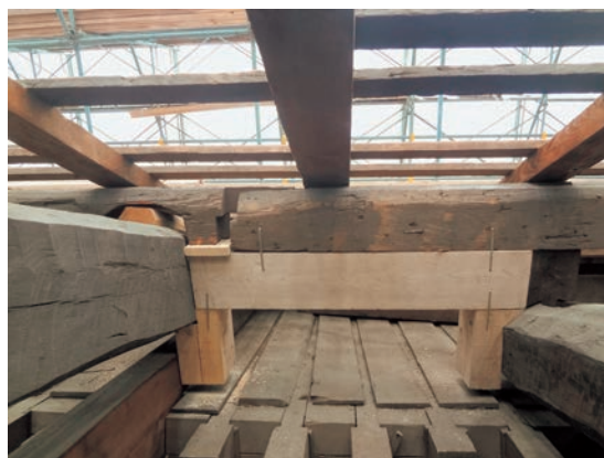
図22 母屋継ぎ目補強
