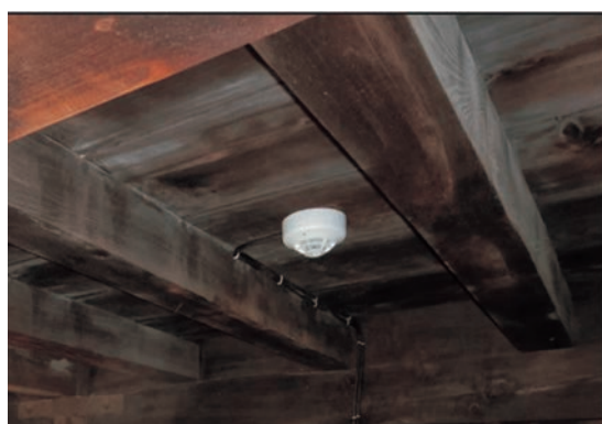
図44 縁下差動式熱感知器
