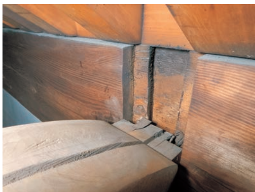
図45 虹梁と桁の接合部
