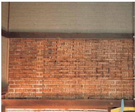
図27 ヘギ板下地状況
