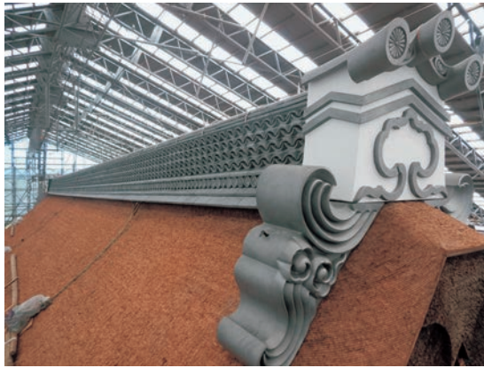
図15 獅子口瓦及び鱗瓦（工事後）
